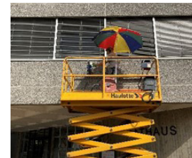
Instandhaltungsarbeiten beim Rathaus.
